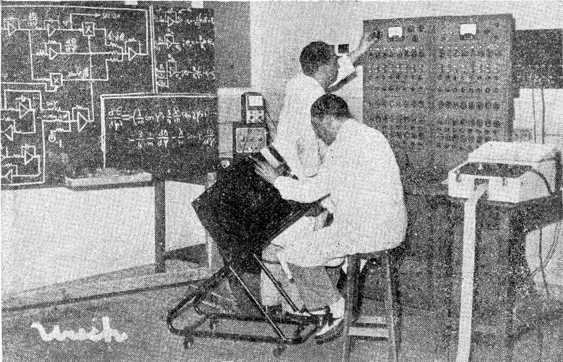
Vista general de la calculadora electrónica construida en el Instituto de Electricidad. En la fotografía aparece el profesor García Santesmases (sentado) observando en el osciló grafo la solución de una ecuación planteada a la máquina (Foto Urech).
